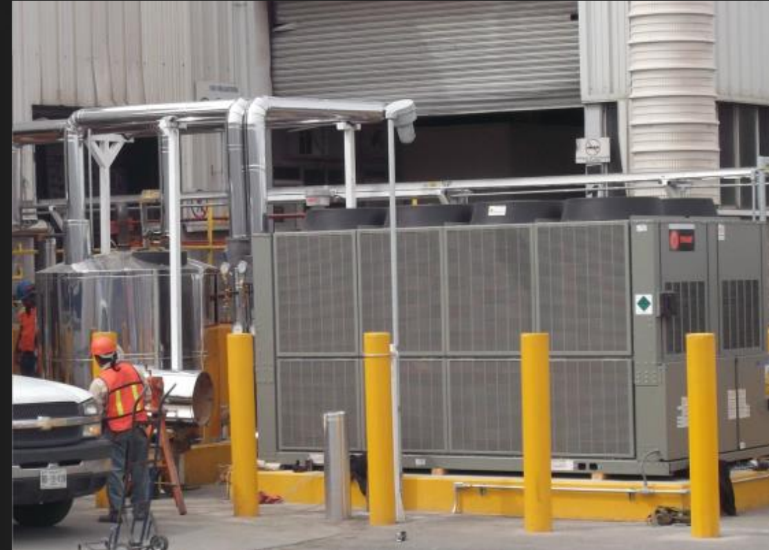
Instalación de chiller y torres de enfriamiento
