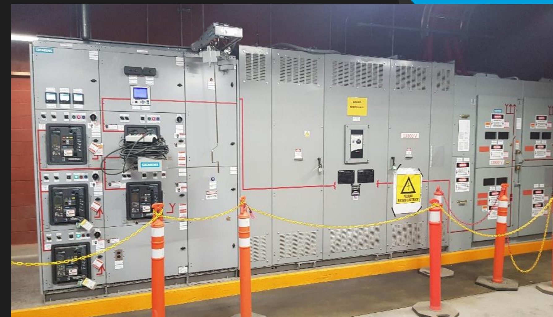
Instalación Subestación 2000 kVA 13.8 kV-480 V. Cableado y conexión.
