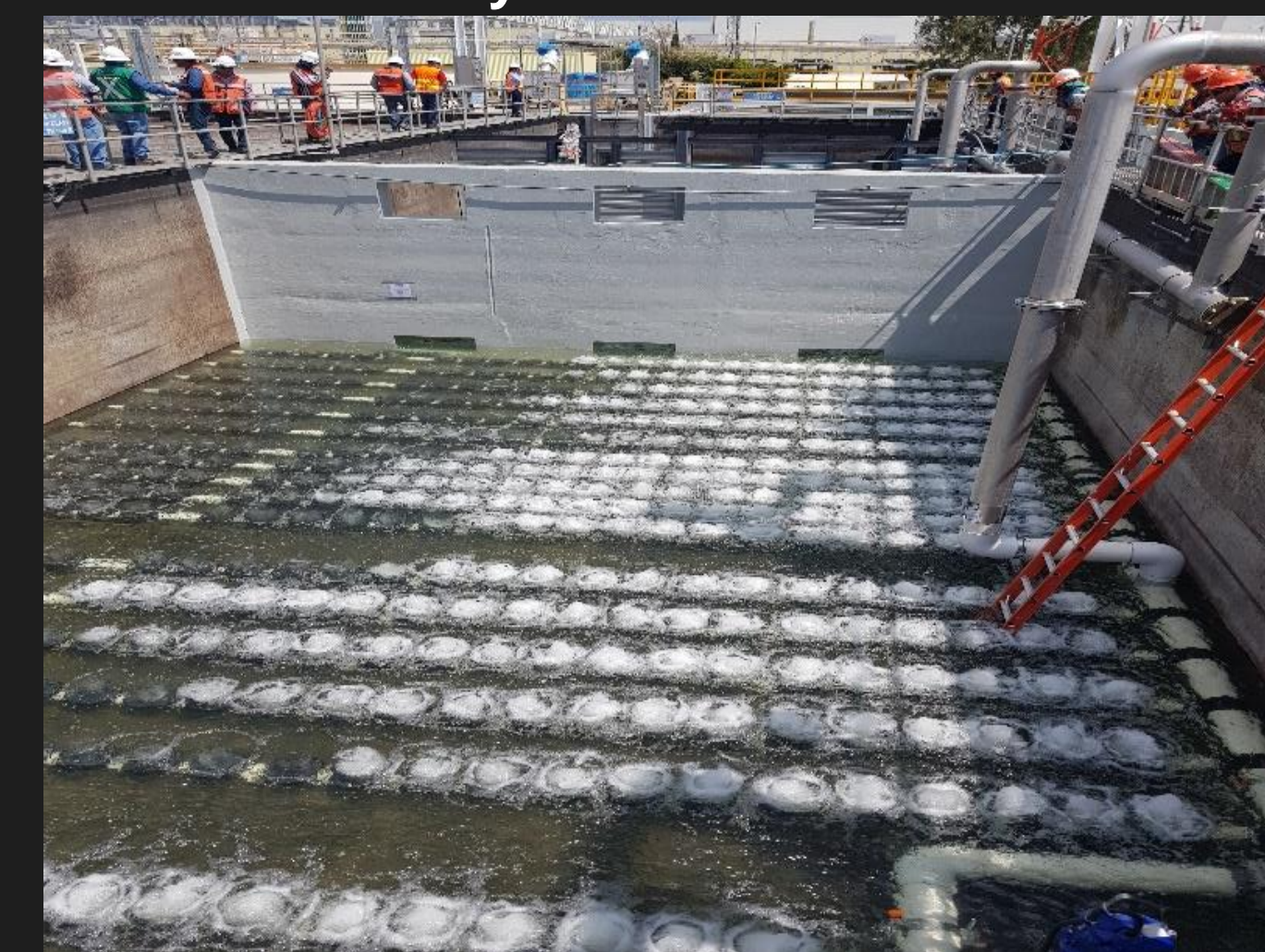
Tren Existente Inst. difusores , tubería inox. Construcción ventanas e inst. Membrana.
