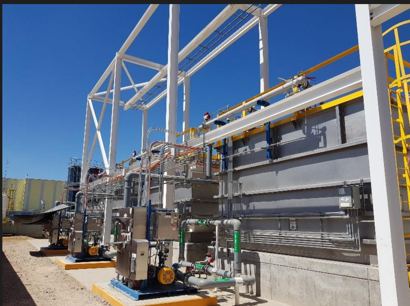
Construcción bases concreto & Inst. equipo MBR (Mecánico , Eléctrico & Control )
